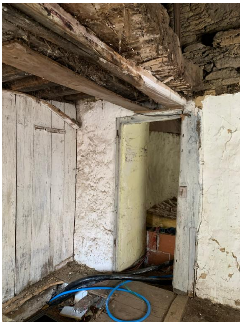
Intérieur, premier étage, pièce ouest
