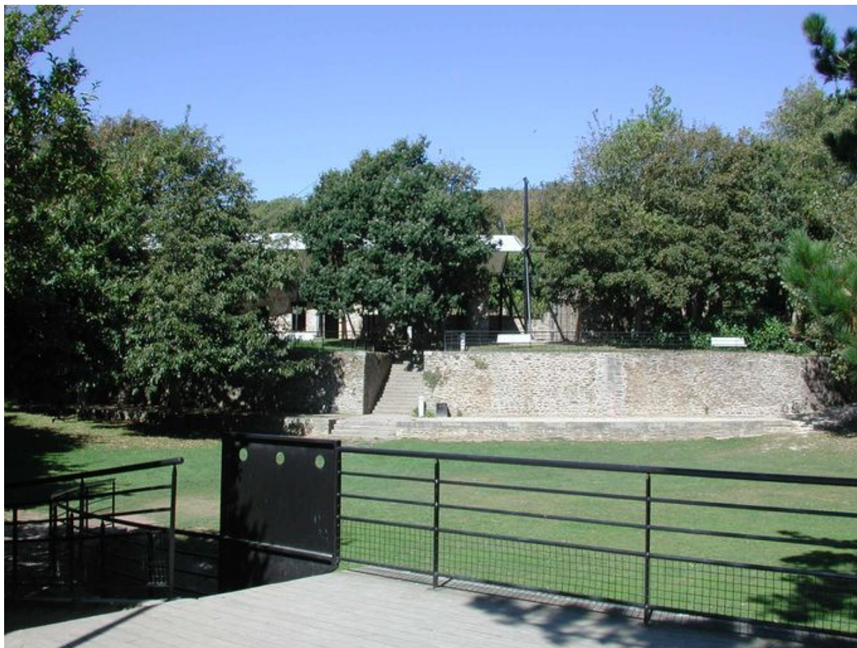
Vue du fort du Dellec : escalier central et vestiges de la caserne aujourd'hui réhabilités
