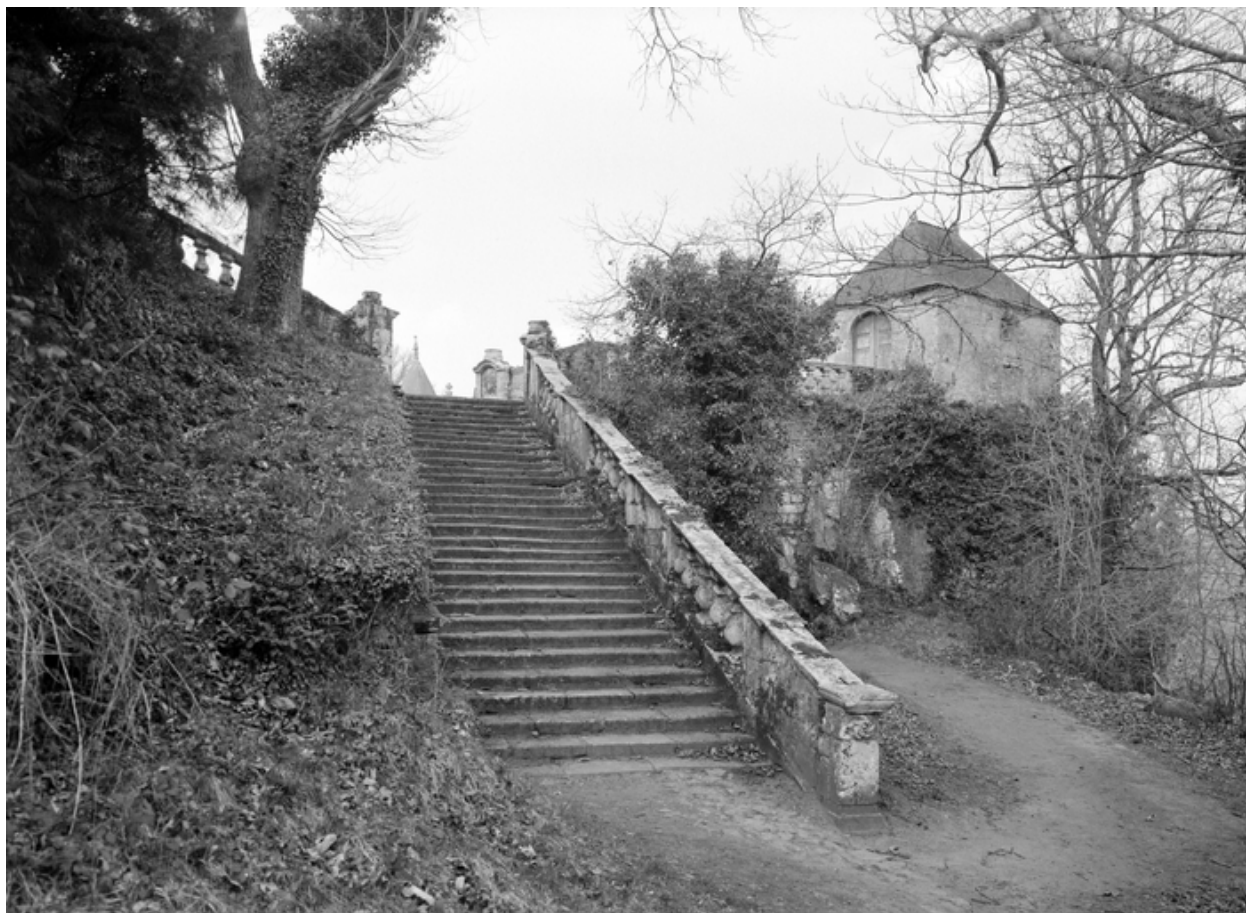
Volée nord des escaliers.
