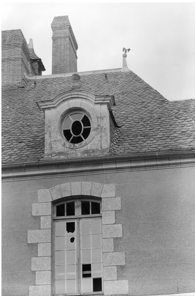
Elévation sud détail de la lucarne.
