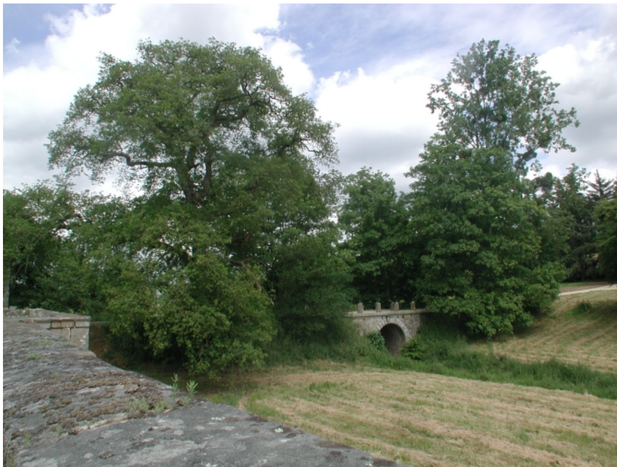
Vue générale de l'accès est
