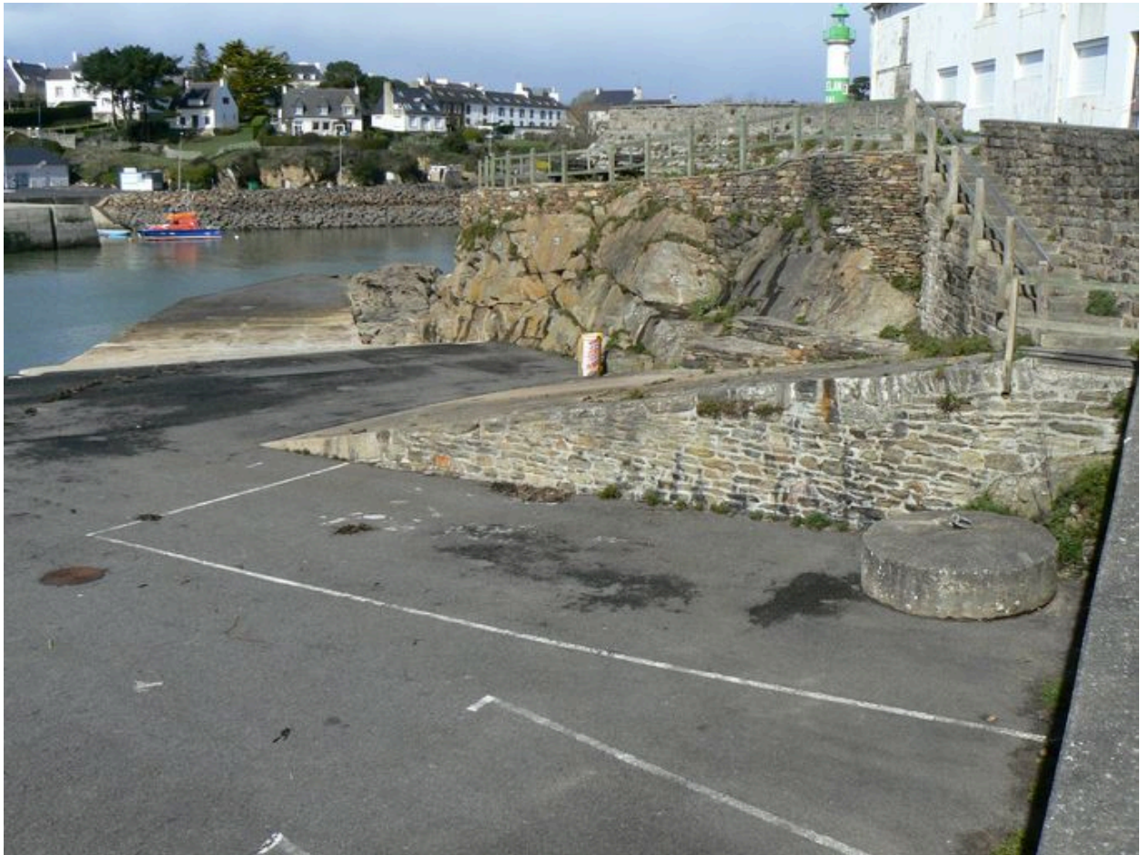
Terre-plein surplombant la cale Cayenne
