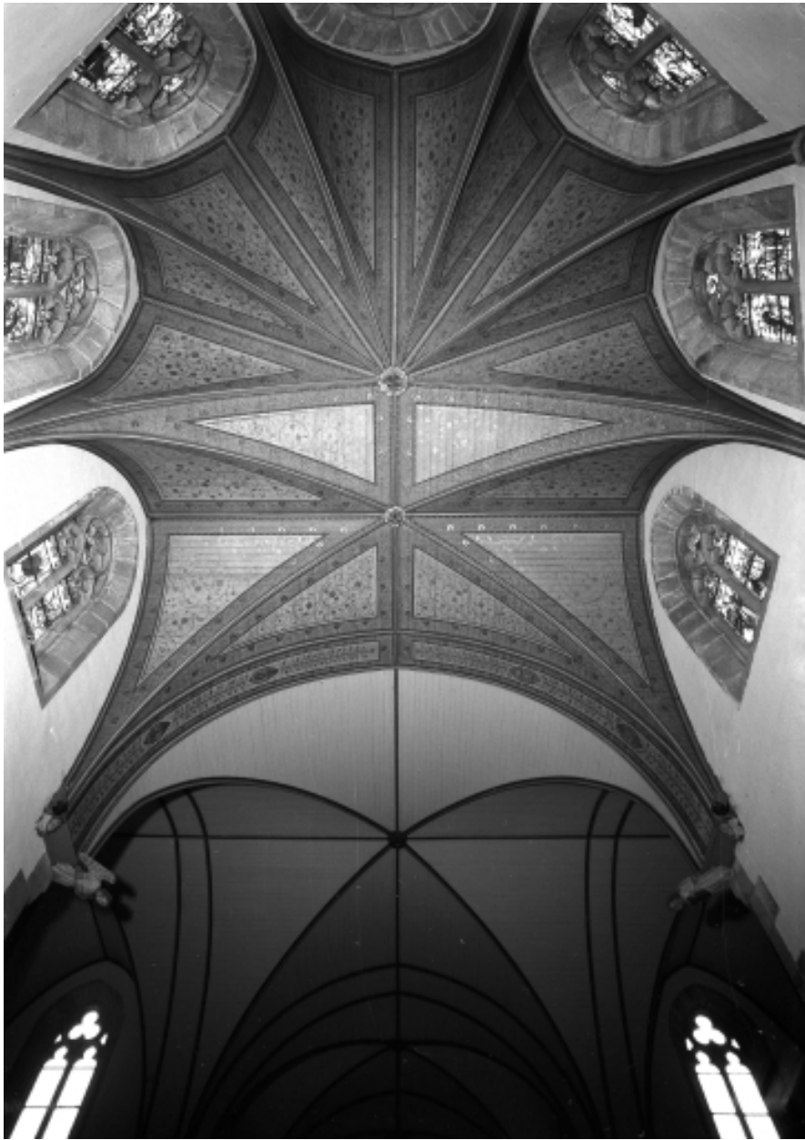
Châteaulin, église paroissiale Saint-Idunet : couverture du choeur, vue d'ensemble, état en 1972
