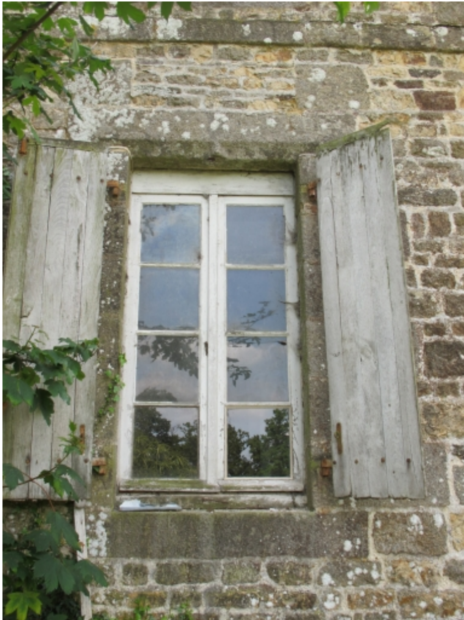
Fenêtre, façade postérieure
