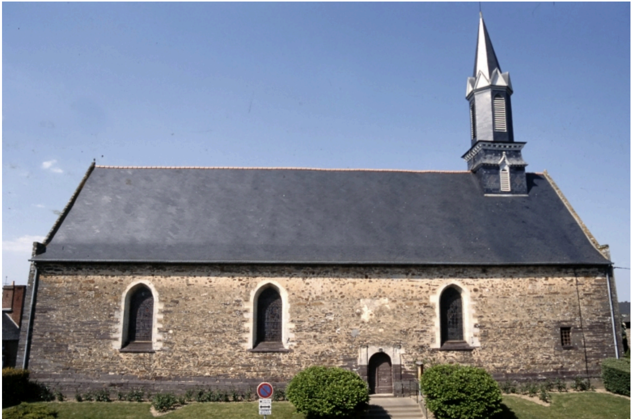
Elévation sud : vue générale.
