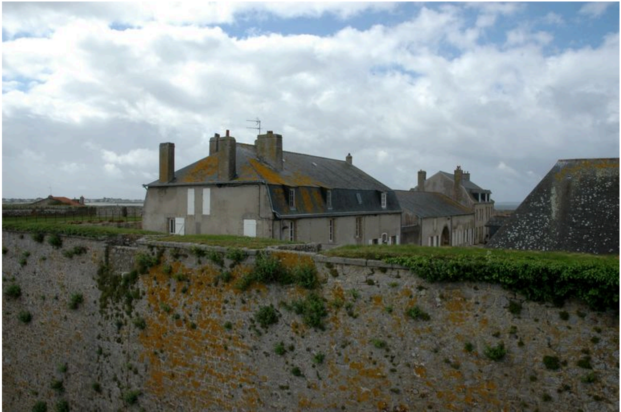
Vue de la citadelle de Port-Louis : caserne Lourmel (du nom du général de Lourmel blessé mortellement lors du siège de Sébastopol)
