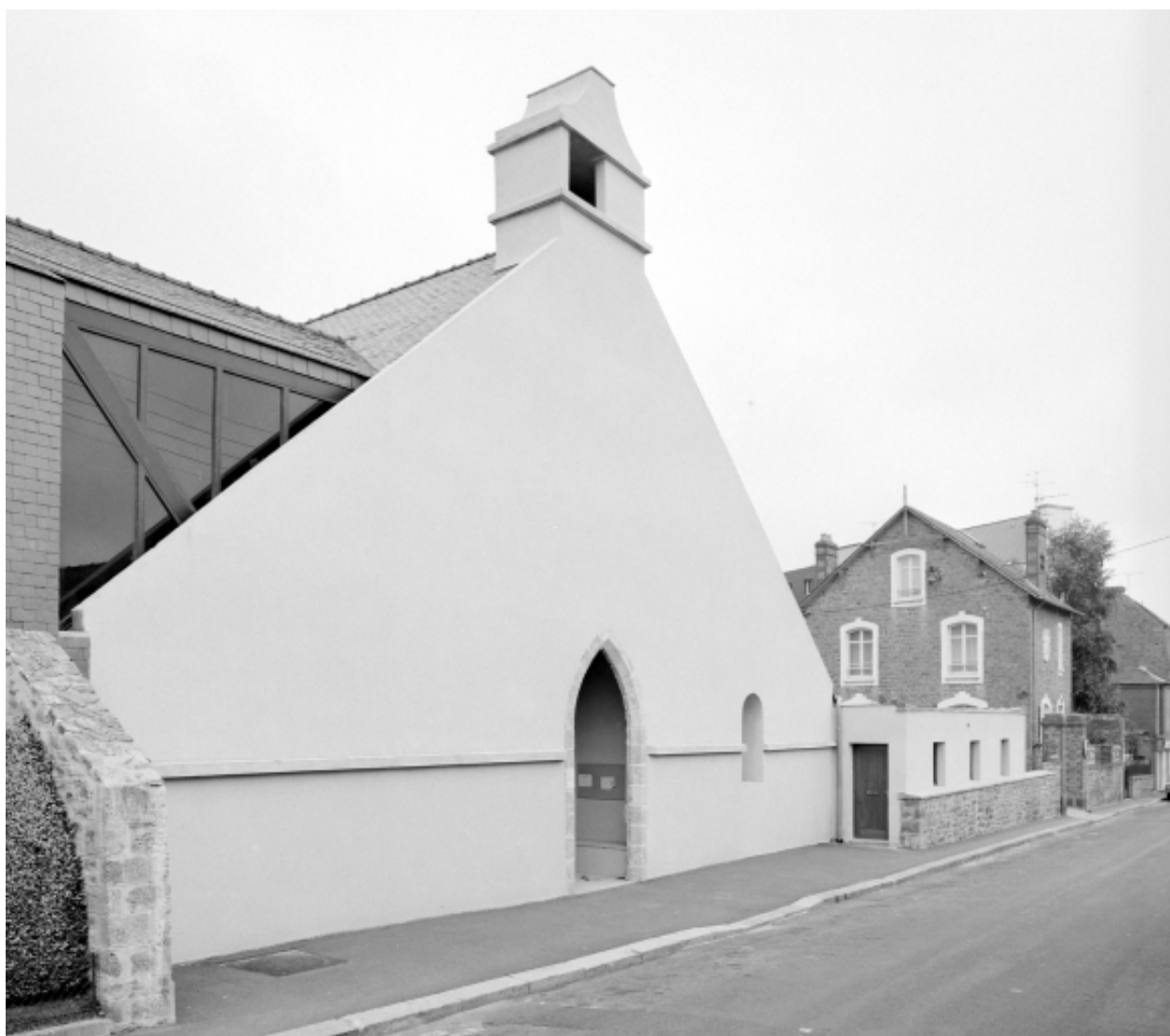
Elévation Sud : vue générale
