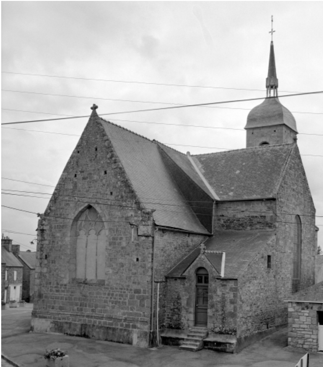
Elévation nord-est : vue générale
