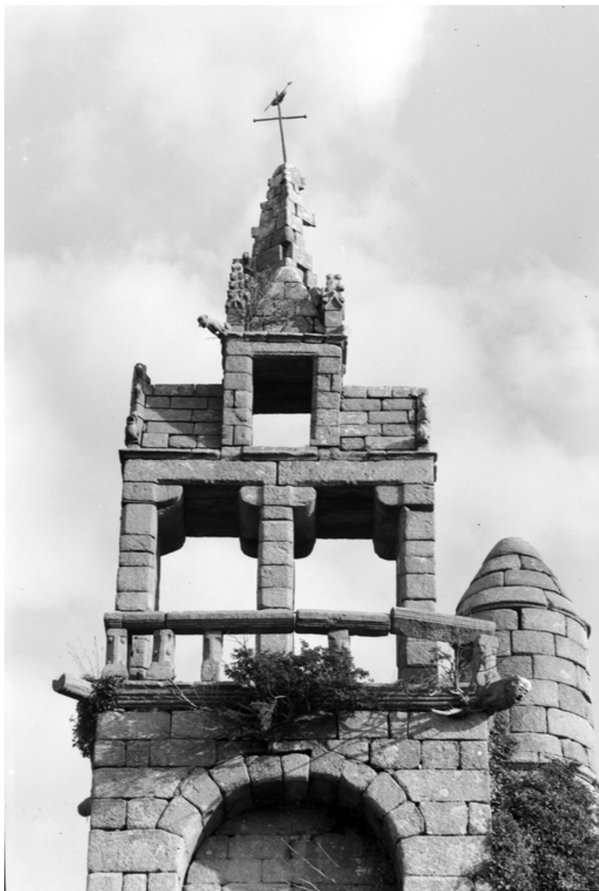
Chambre des cloches
