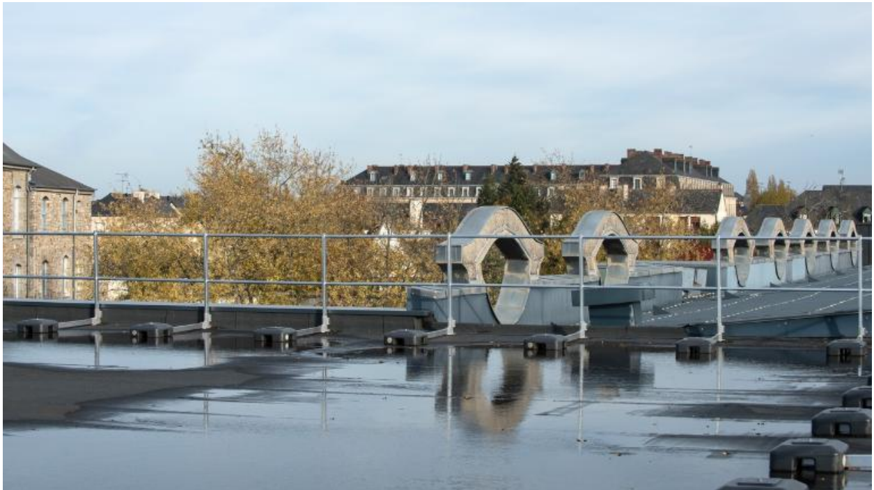
Toits du bâtiment C.
