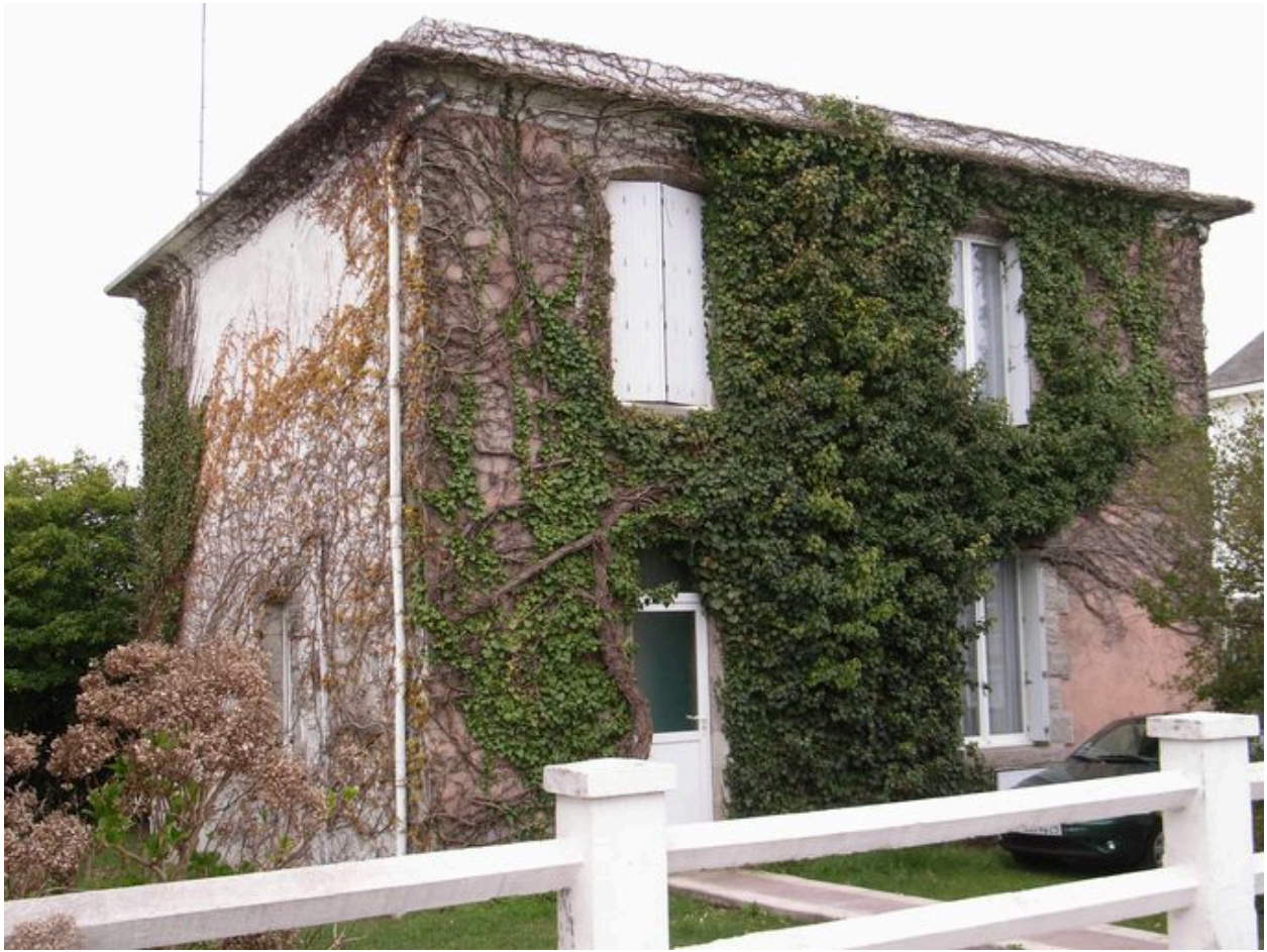
Pignon sud et façade de la villa Les Bleuets
