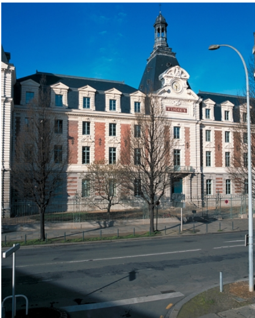
Détail de la façade sur l'avenue Jean-Janvier
