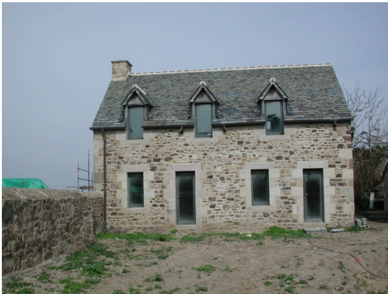
Vue du bâtiment isolé fermé par un mur sur la partie Nord-Ouest
