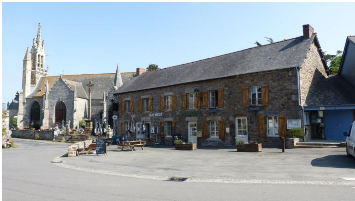
Vue générale sud
