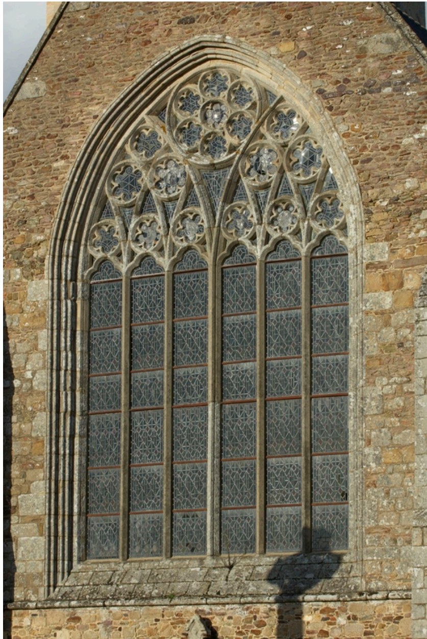
Vue de détail de la baie du transept sud
