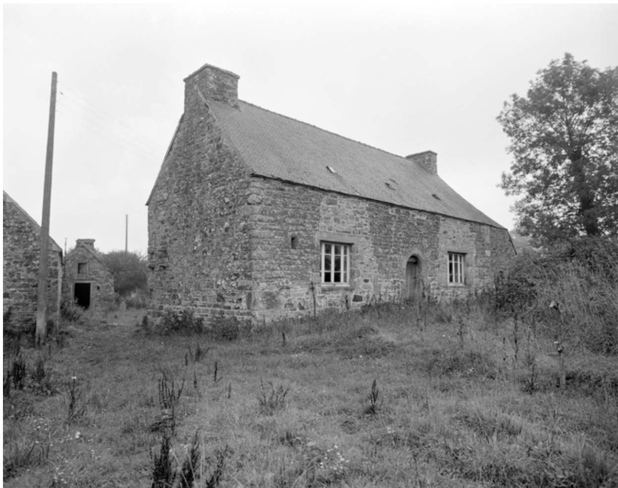
Façade ouest : vue générale
