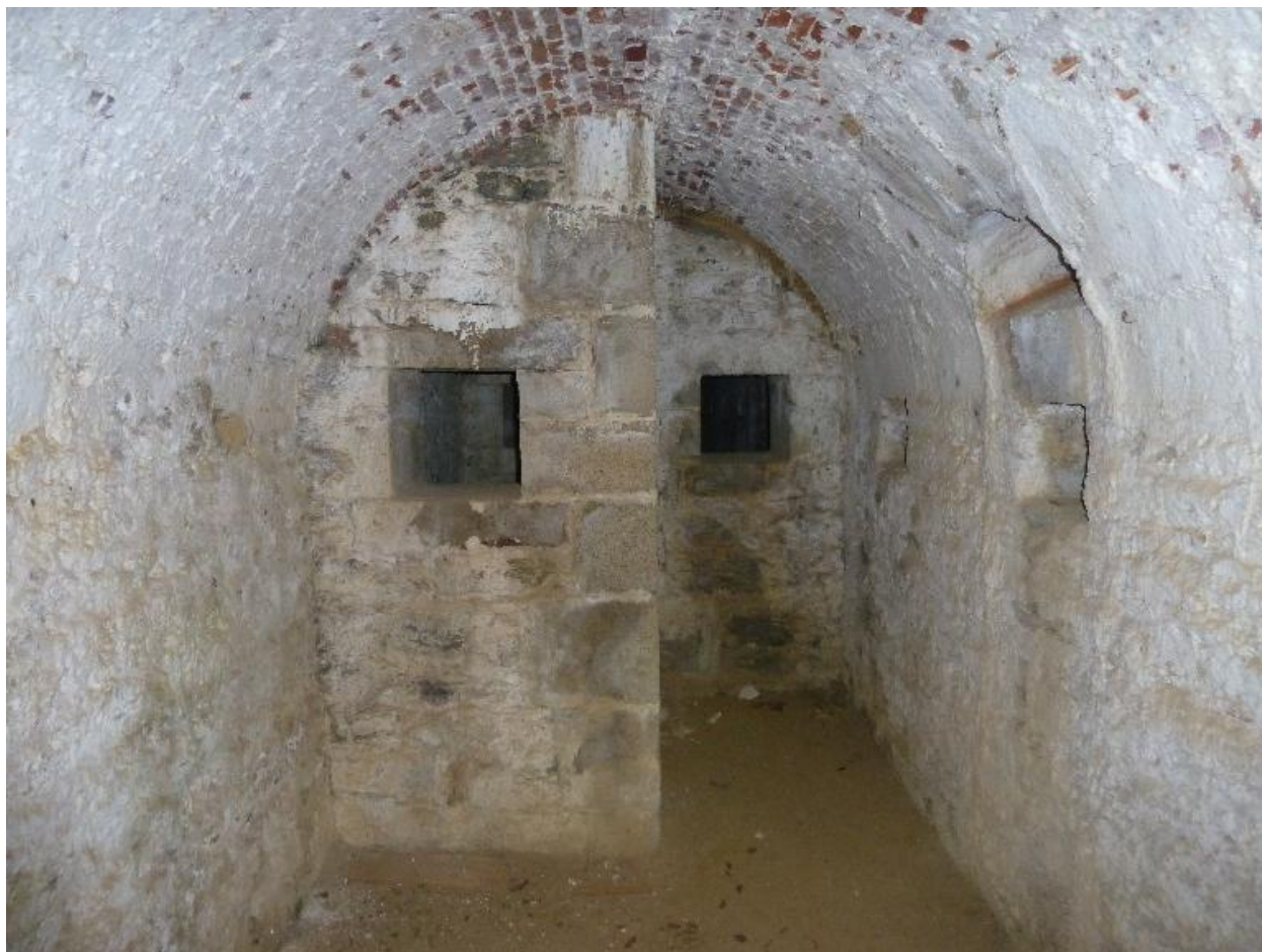
Le Palais, enceinte urbaine, galerie de contrescarpe, casemate des extrémités, chicane.
