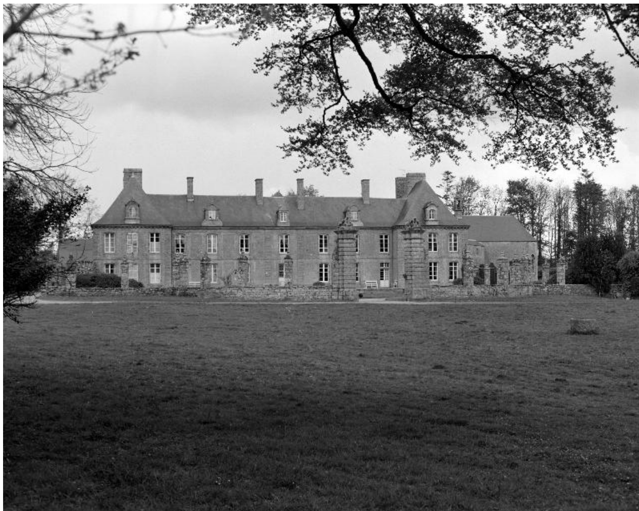
Vue générale prise du sud.
