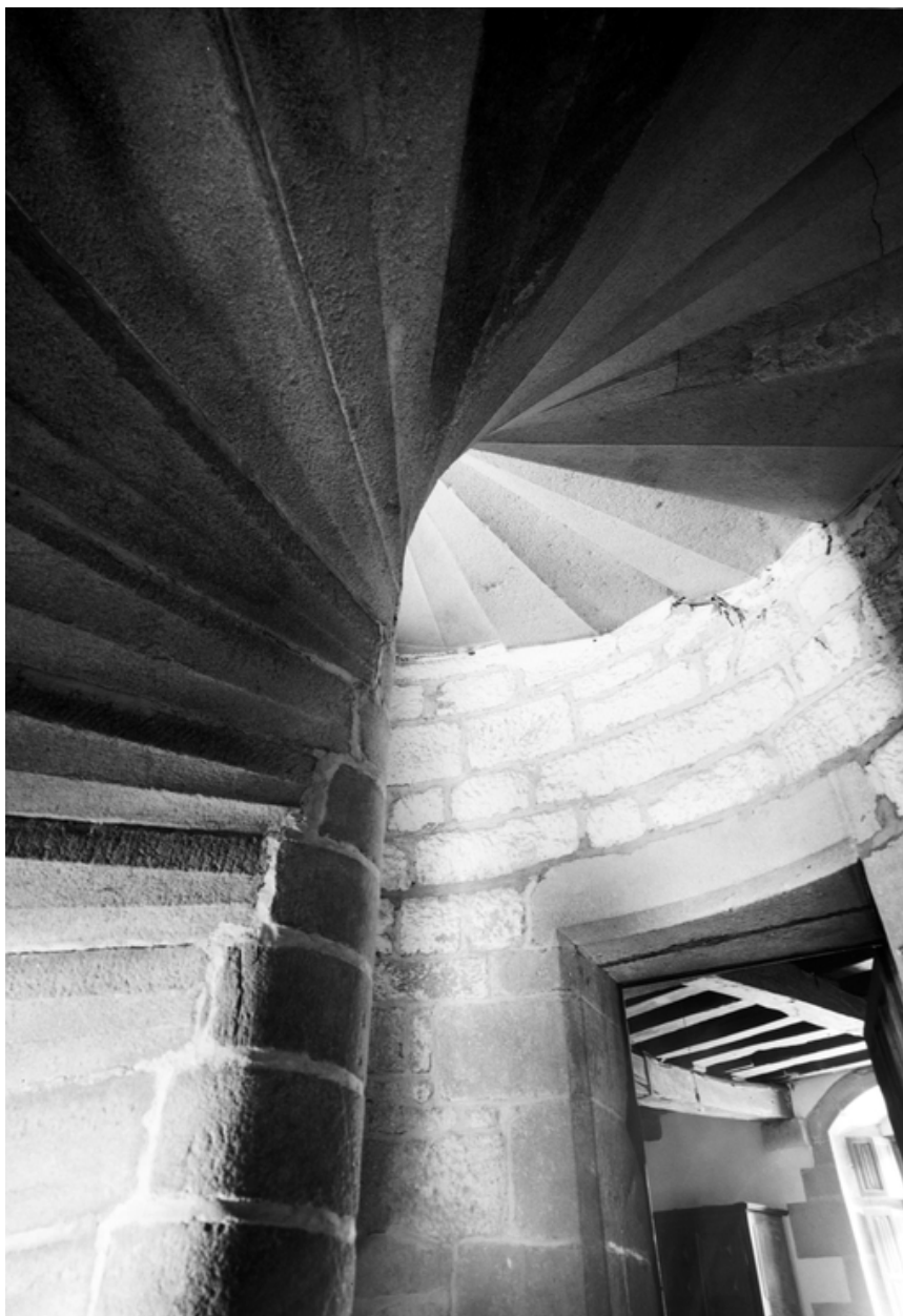
Logis, étage : escalier principal ouest
