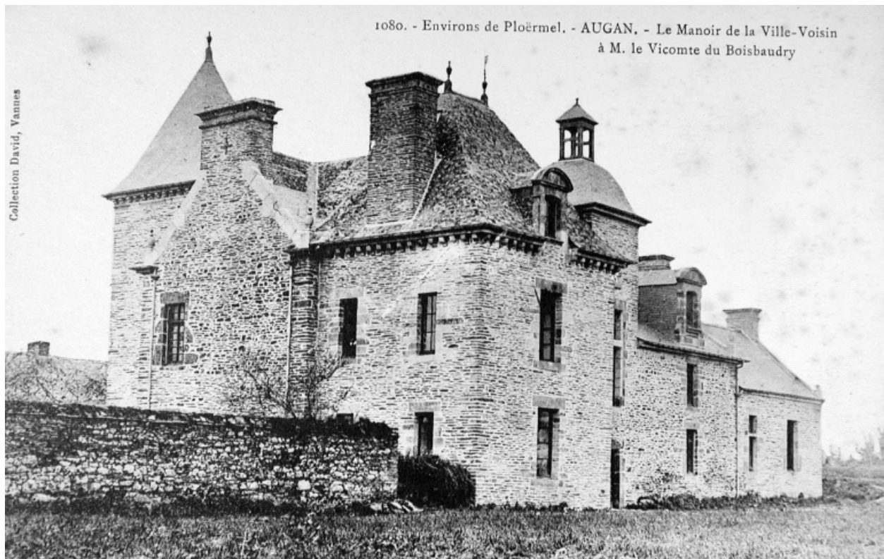
Élévation postérieure, vue de trois-quart
