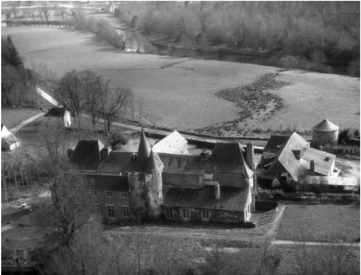
Vue aérienne : vue générale nord
