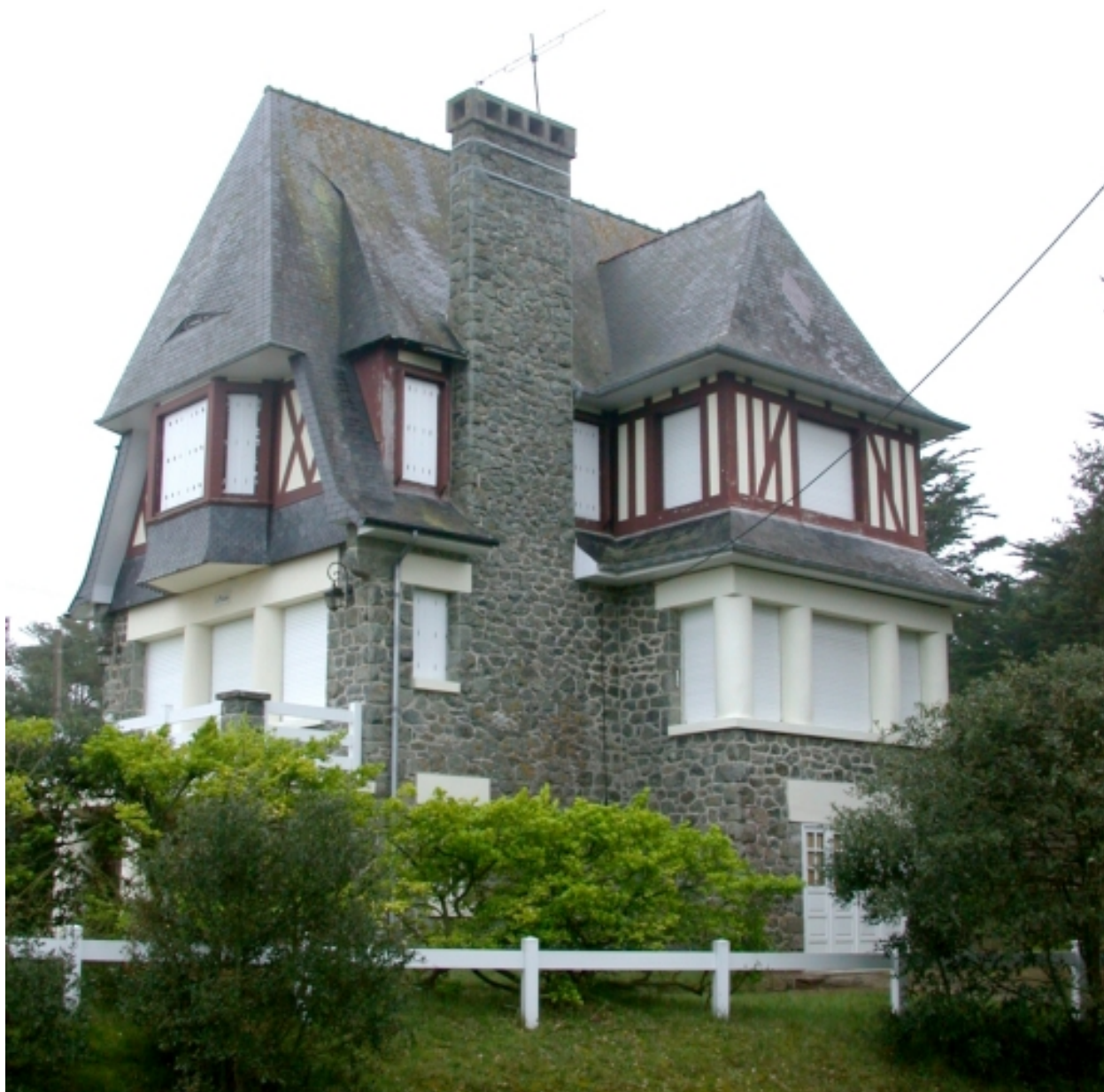
Vue générale (angle nord-ouest)
