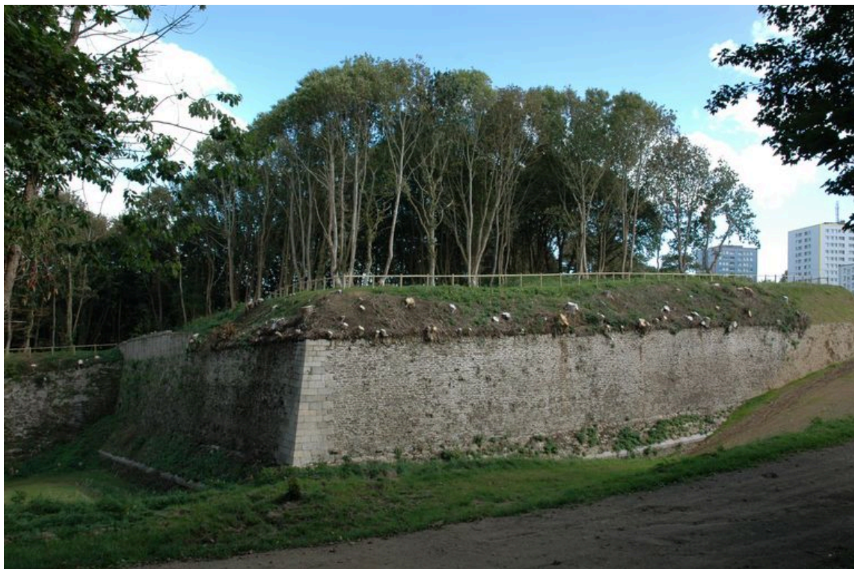
Vue de l'ouvrage à cornes de Quéliverzan
