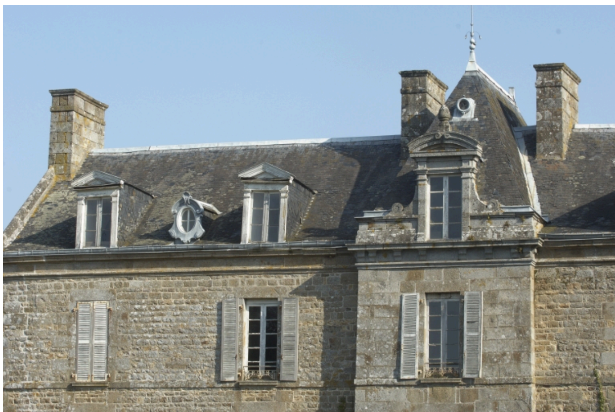
Détail des toitures
