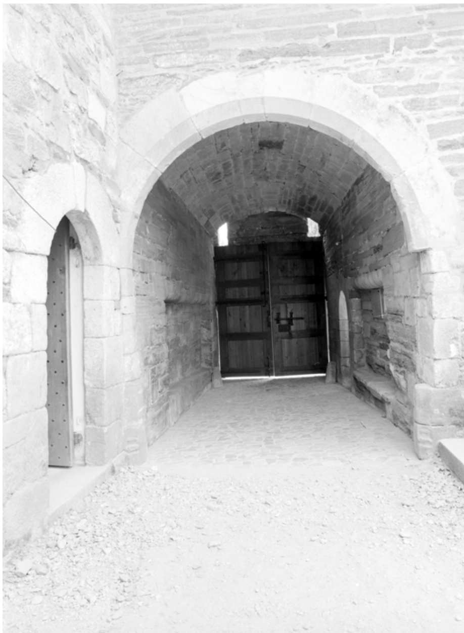
Pont-levis, vue intérieure.
