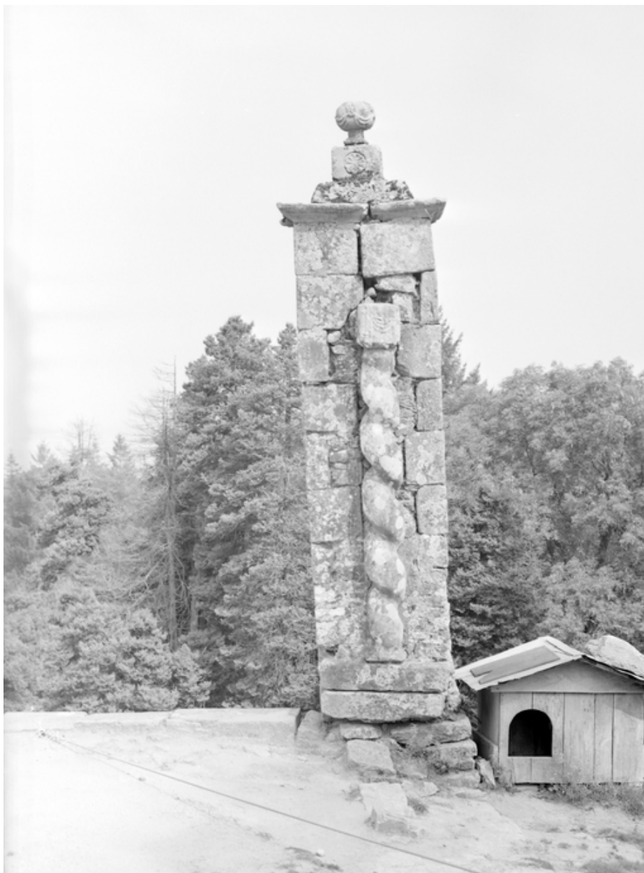
Terrasse, pilier sud : élévation ouest.
