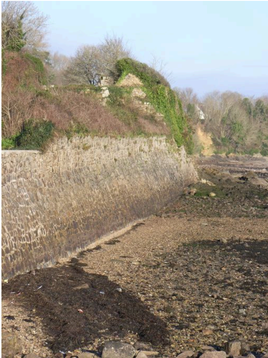
Mur de soutènement dans la continuité de la digue-route de Quéléren
