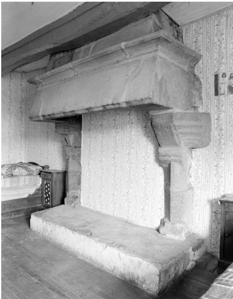
Cheminée de l'étage : vue générale
