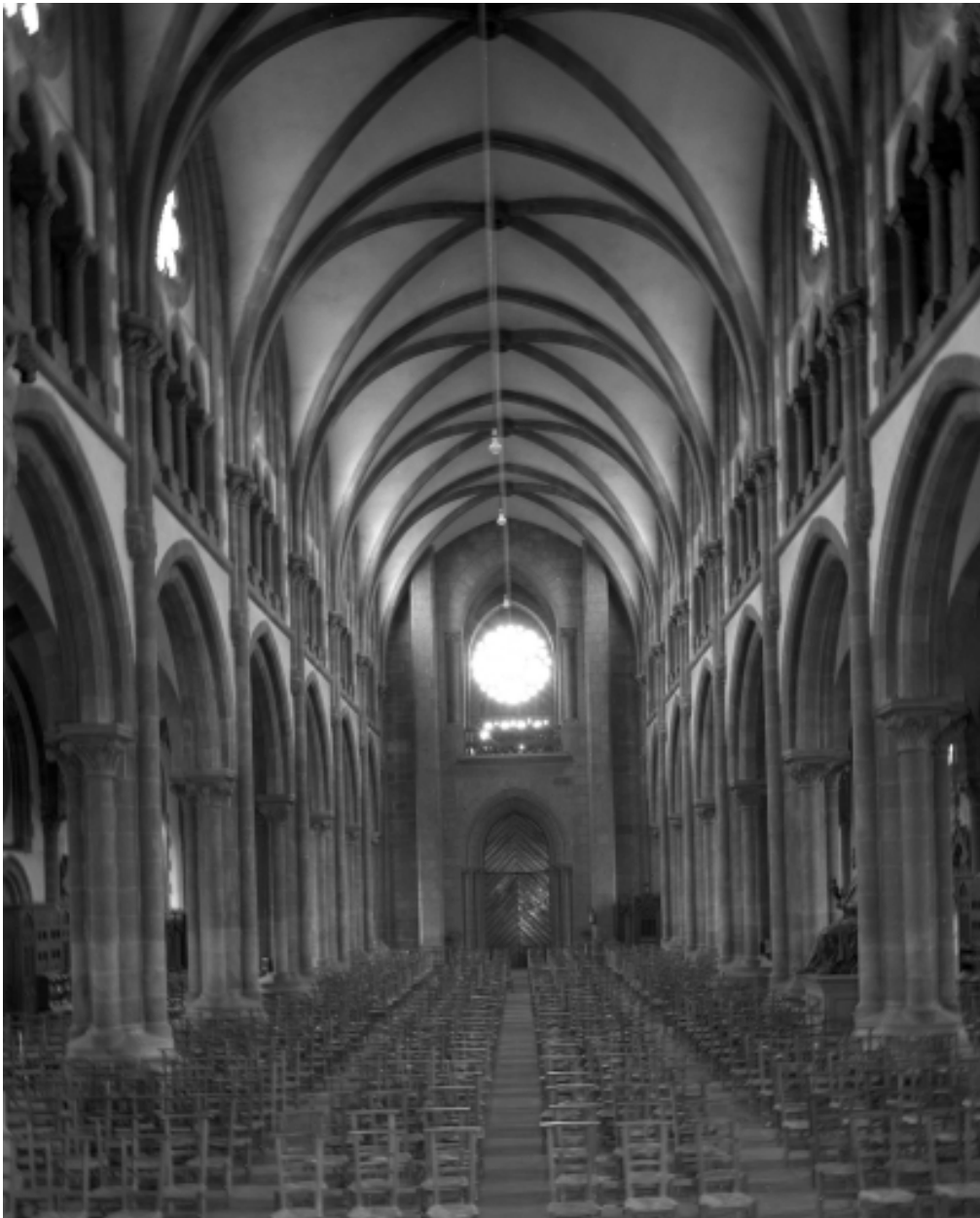
Douarnenez, église du Sacré-Coeur : vue intérieure vers l'ouest, état en 1984
