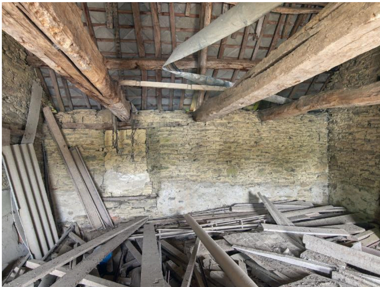
Logis 1706. Chambre de l'étage. Ouverture bouchée sur le mur ouest
