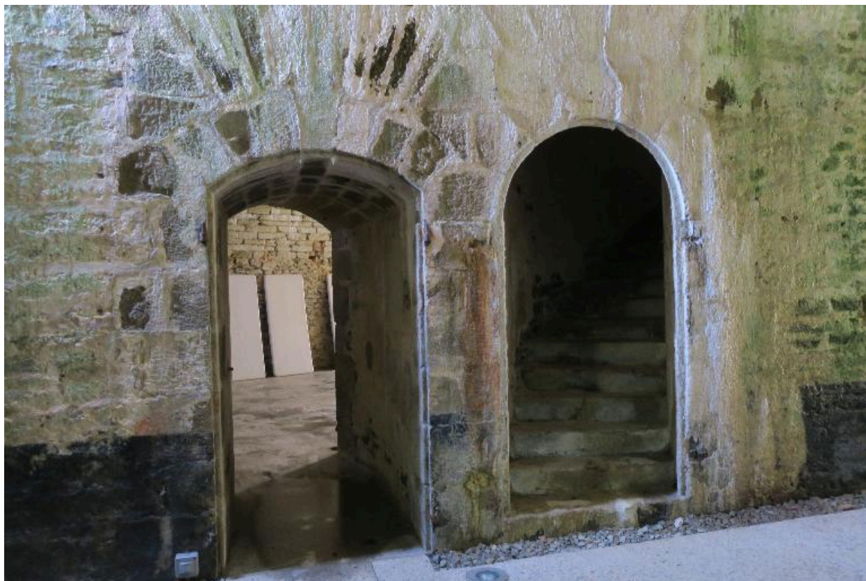
Le Palais, enceinte urbaine, réduit B, départ de l'escalier de gauche.
