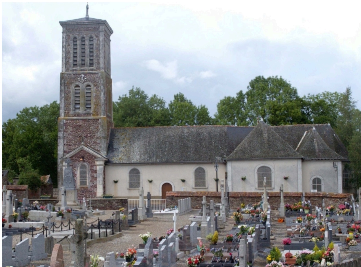
Vue générale sud depuis le cimetière
