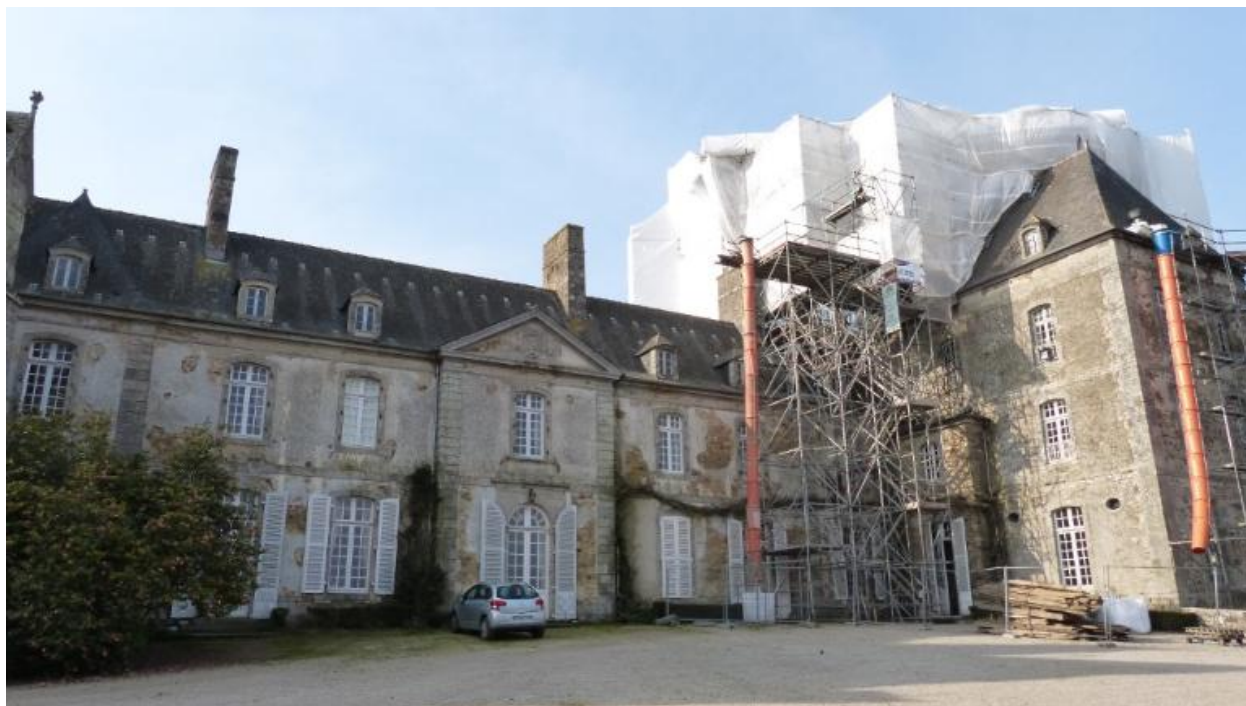
Vue de la façade est du château
