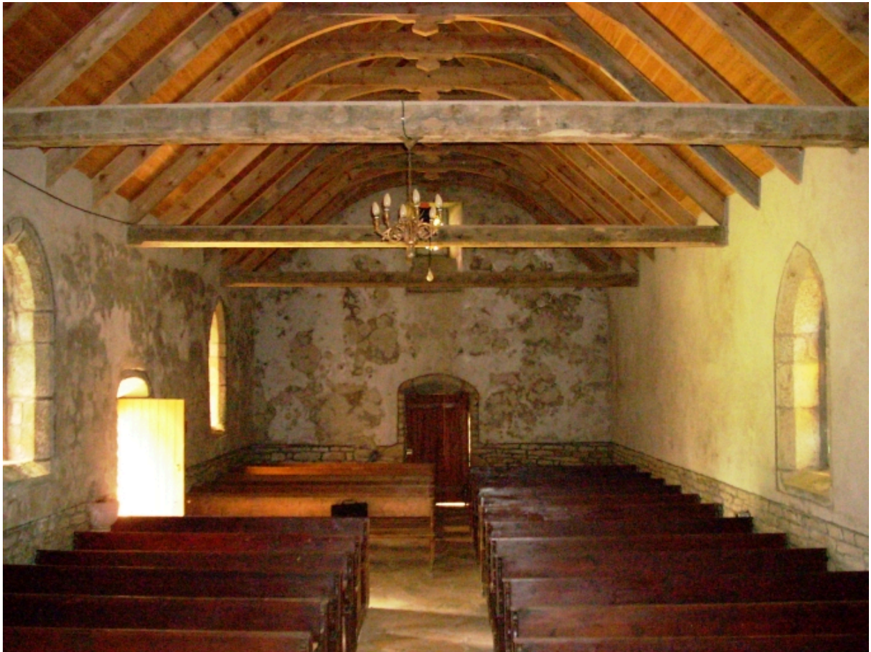
Ploudalmézeau, chapelle Saint-Roch : vue axiale ouest
