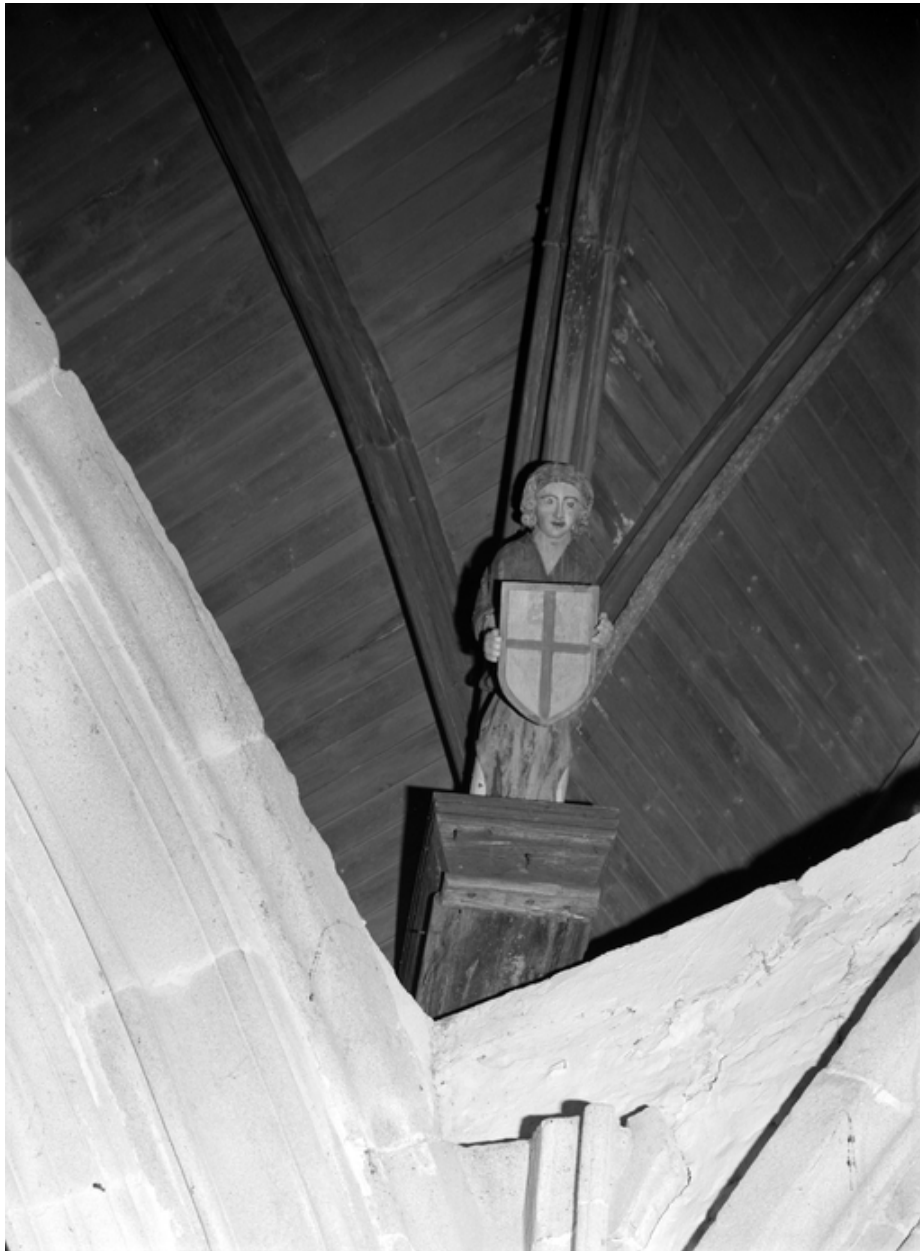
Croisée du transept, lambris, corbelet sud-est.
