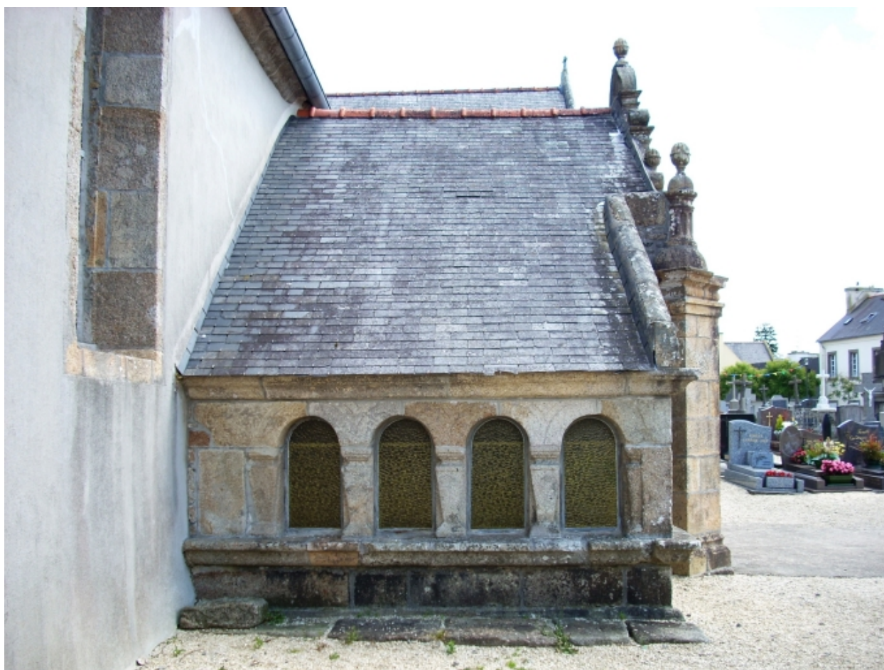
Guilers, église paroissiale : détail ossuaire
