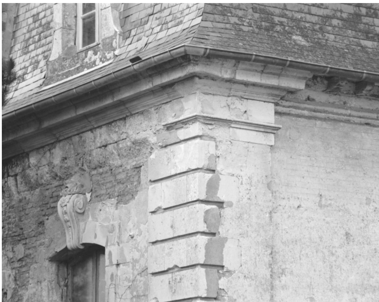
Façade sud ; pavillon est, détail
