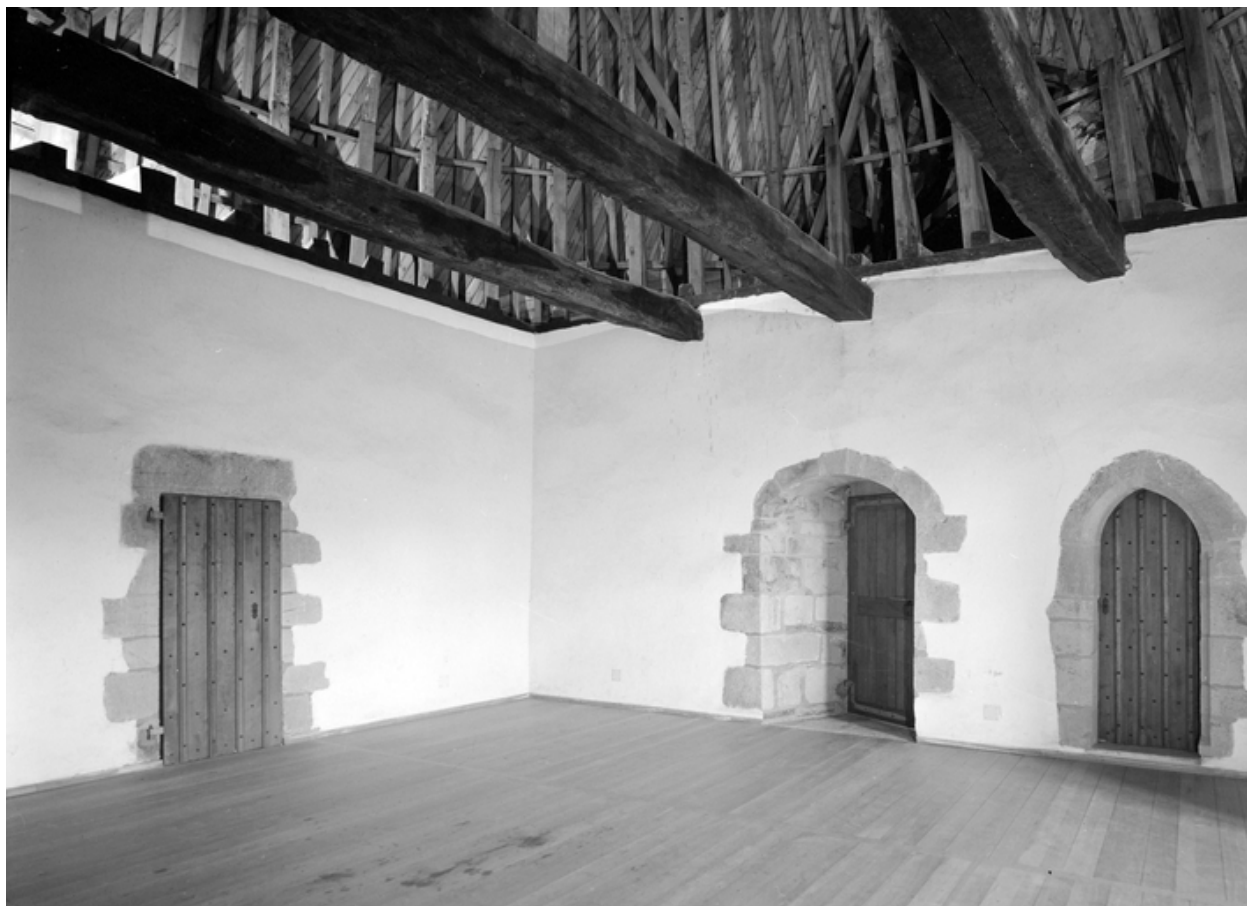
Tour sud-ouest, troisième niveau, vue vers le nord-est.
