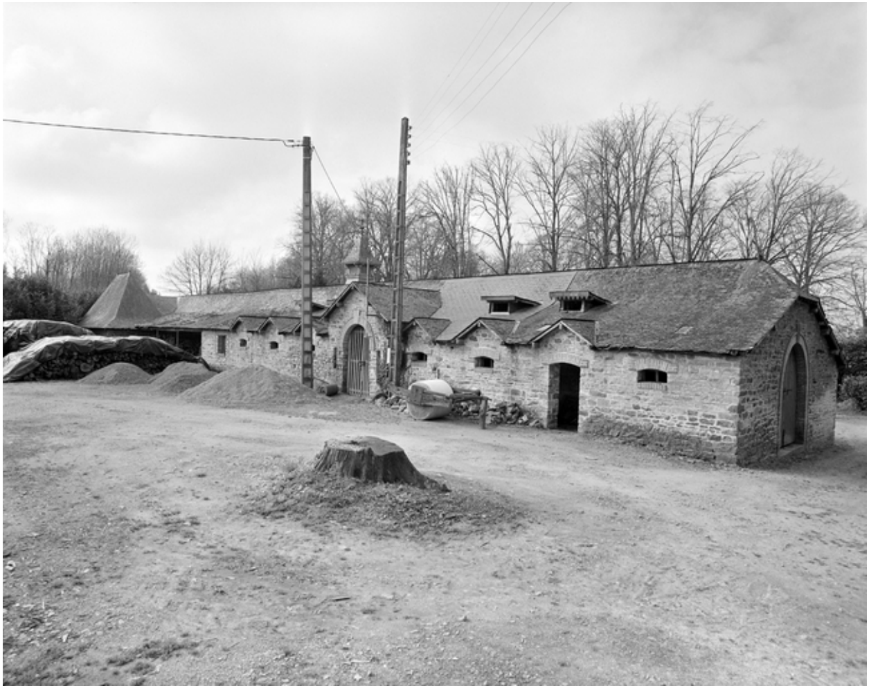
Vue générale des anciennes écuries.
