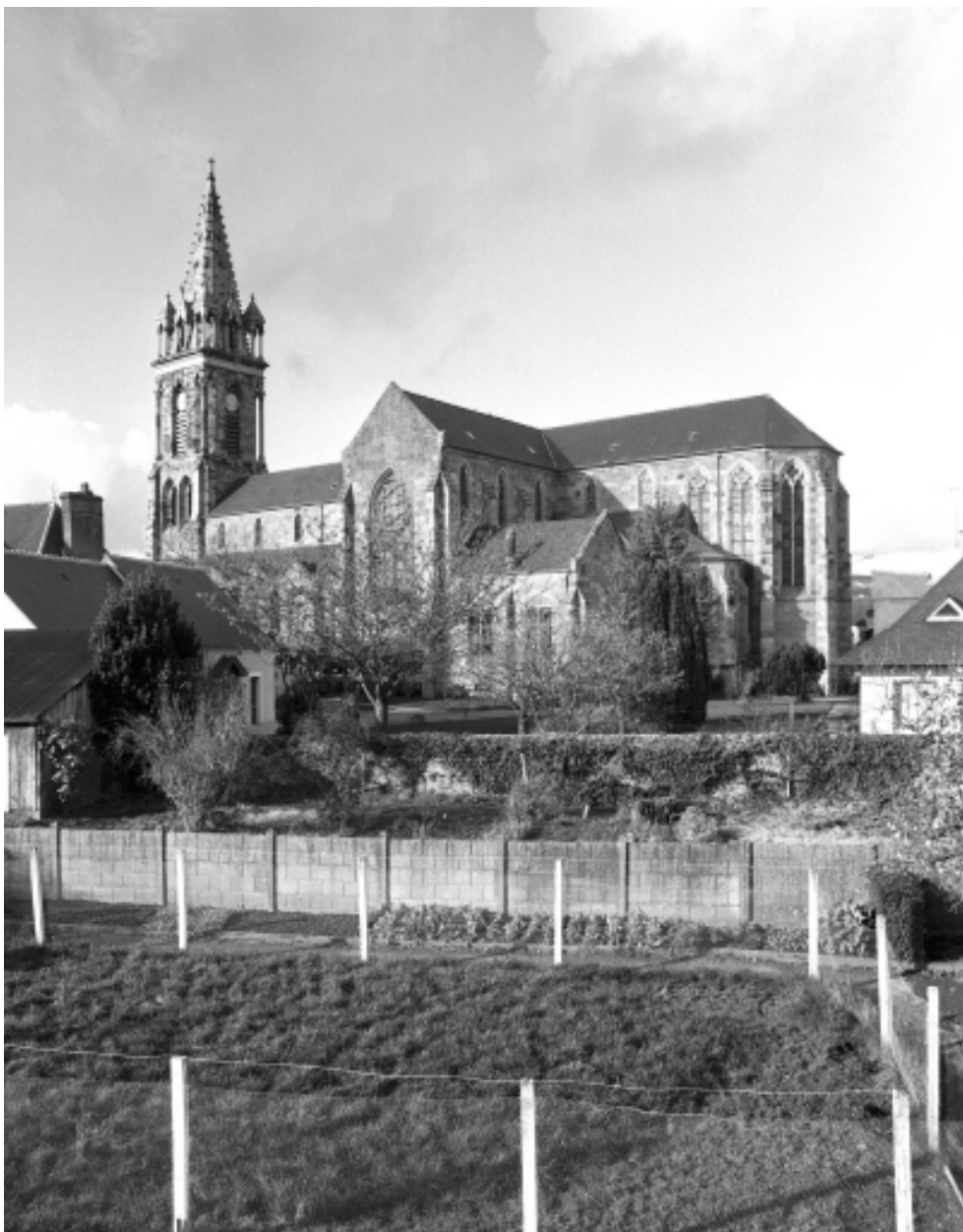
Elévation sud est ; vue générale
