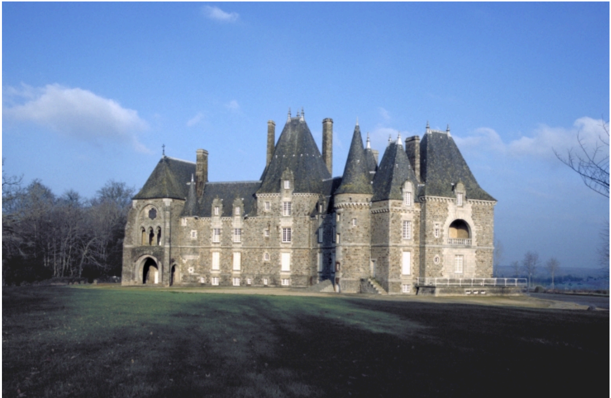
Vue générale, façade antérieure, vue rapprochée
