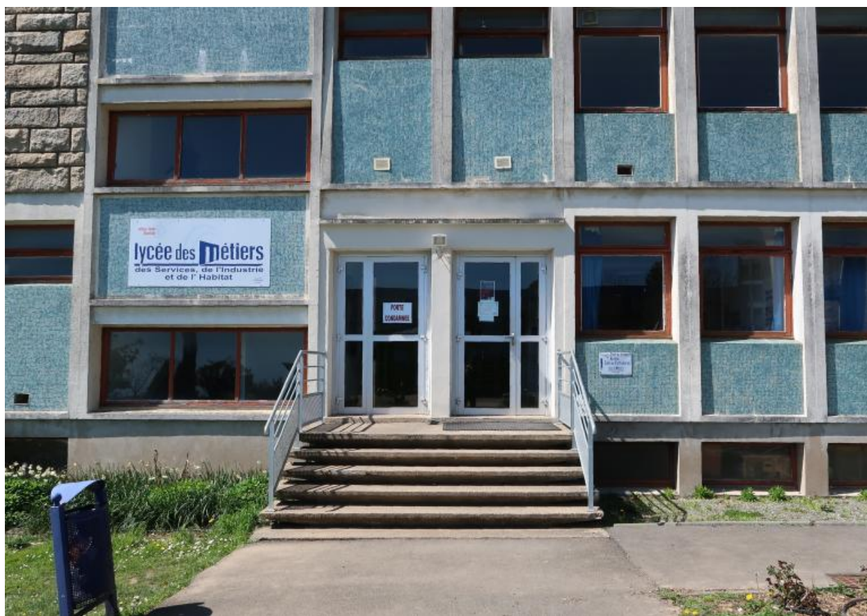
L'entrée des ateliers, sur la façade sud-est.
