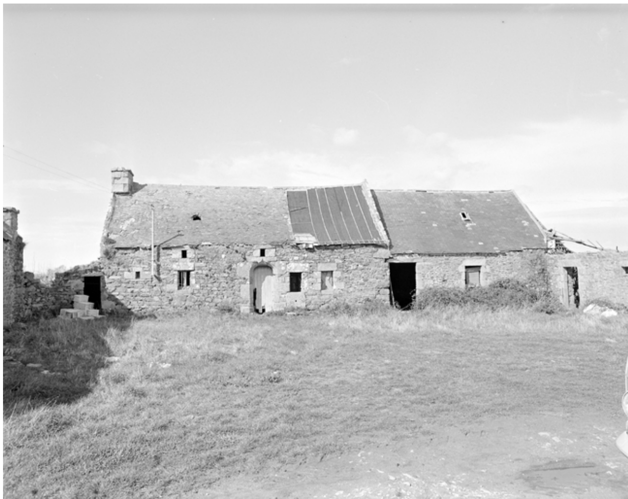
Vue générale antérieure sud. (1979)
