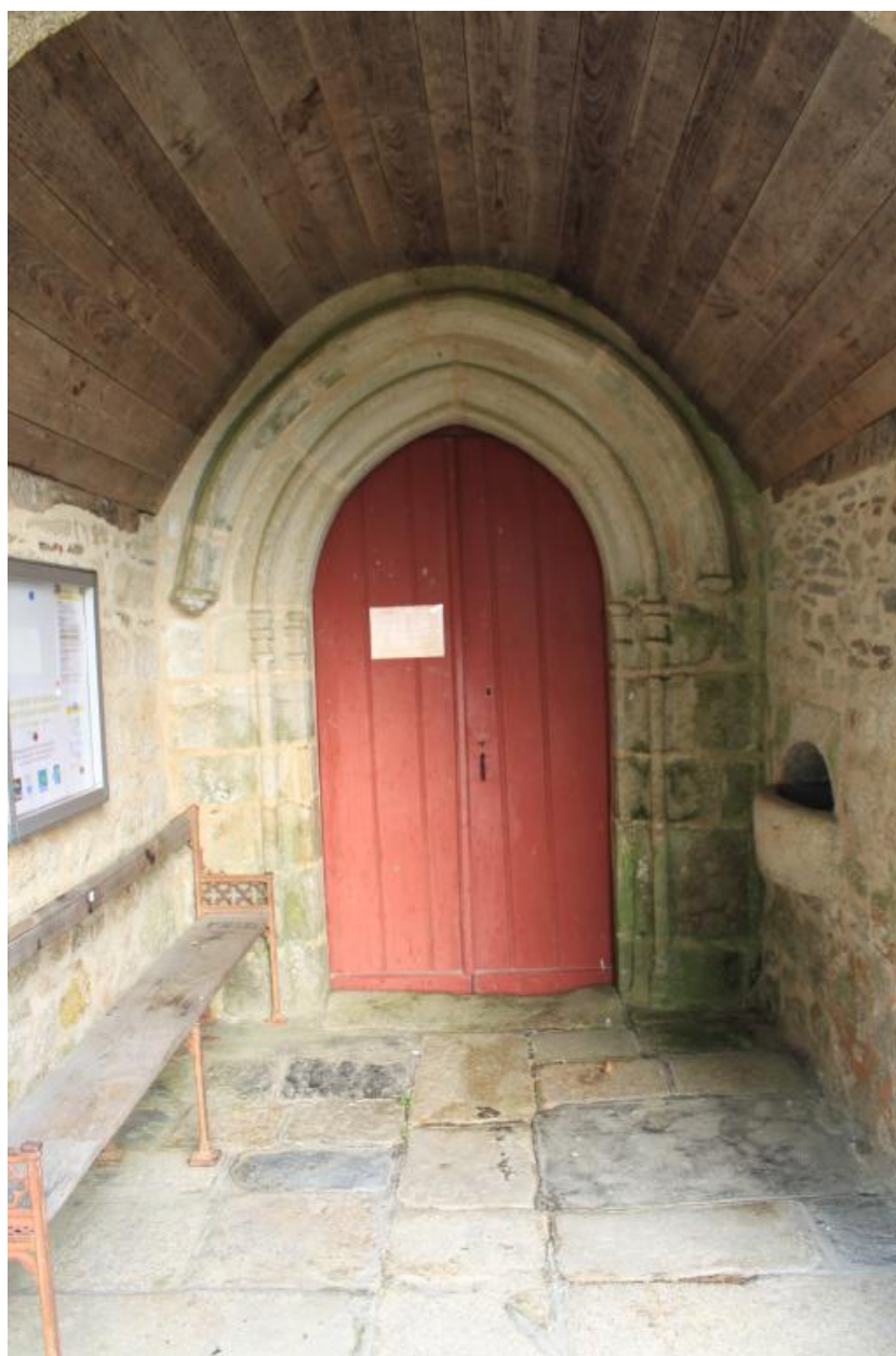
Eglise Saint-Mériadec de Stival, Pontivy, Porte sud.
