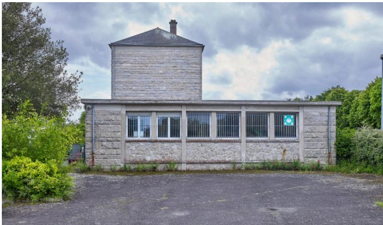
Infirmerie de garçons et internat de filles, façades nord. Patrice Simon, architecte, 1966.
