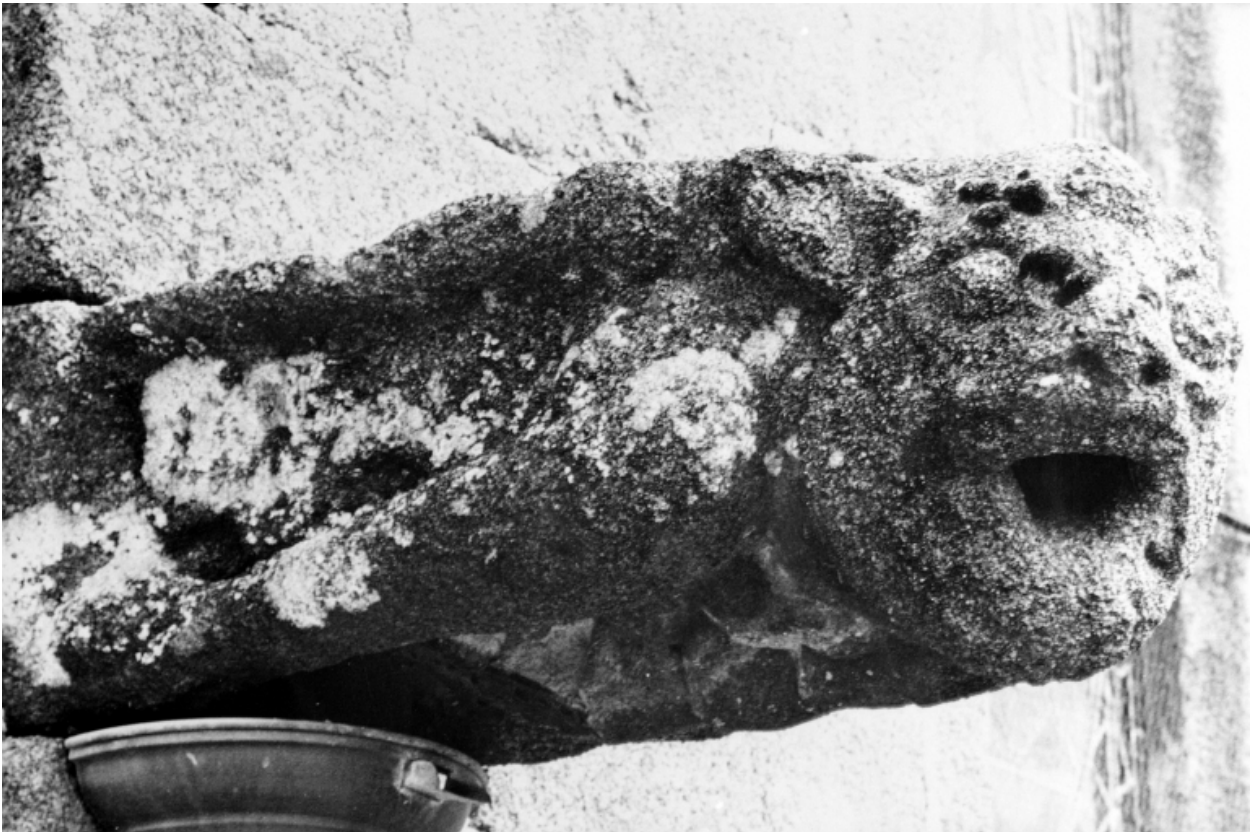
Façade sud, détail gargouille.
